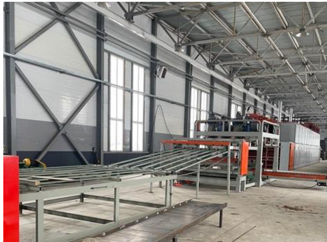
Приобретено и смонтировано оборудование в том числе окорочный комплекс, парильная камера, луцильный станок, конвейер, сушильная камера
