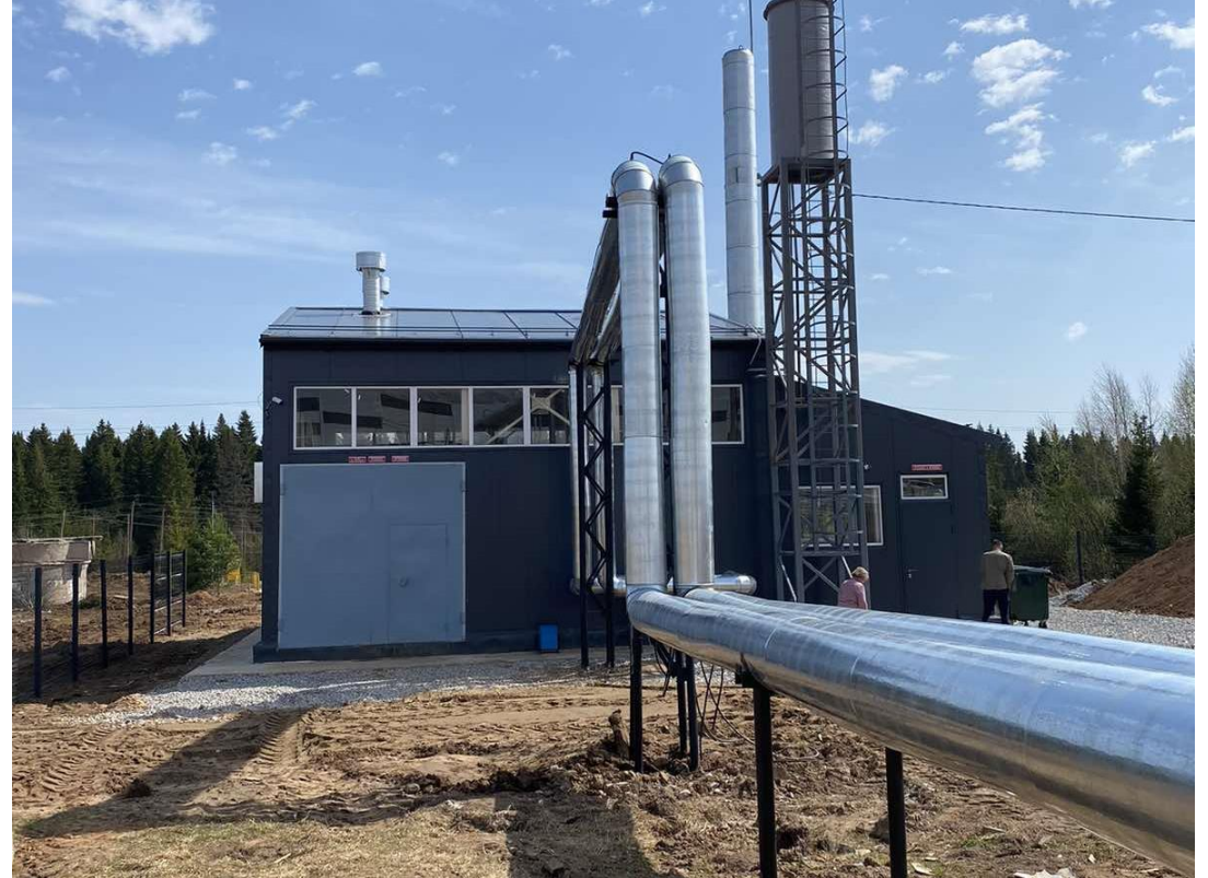
Построен маслопровод от котельной до цеха
