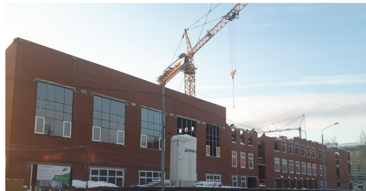
Реконструкция корпуса МАОУ «СОШ 93», г. Пермь
